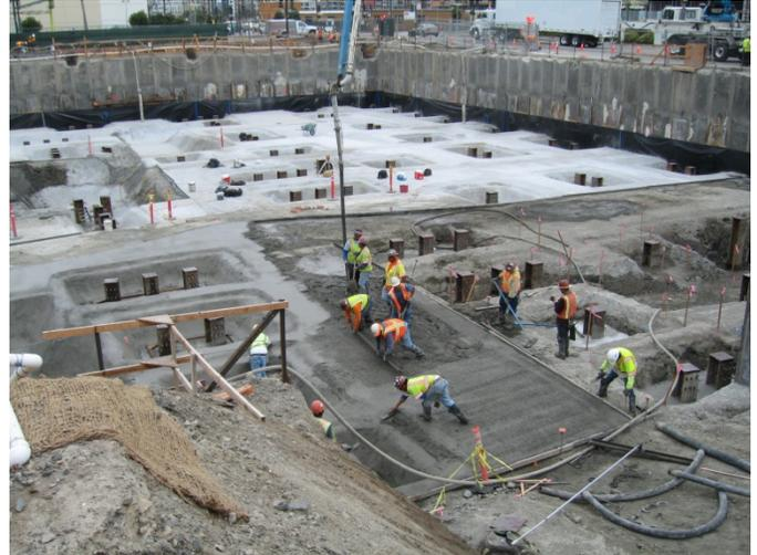
Mud-slab pour and finish at Basement level
